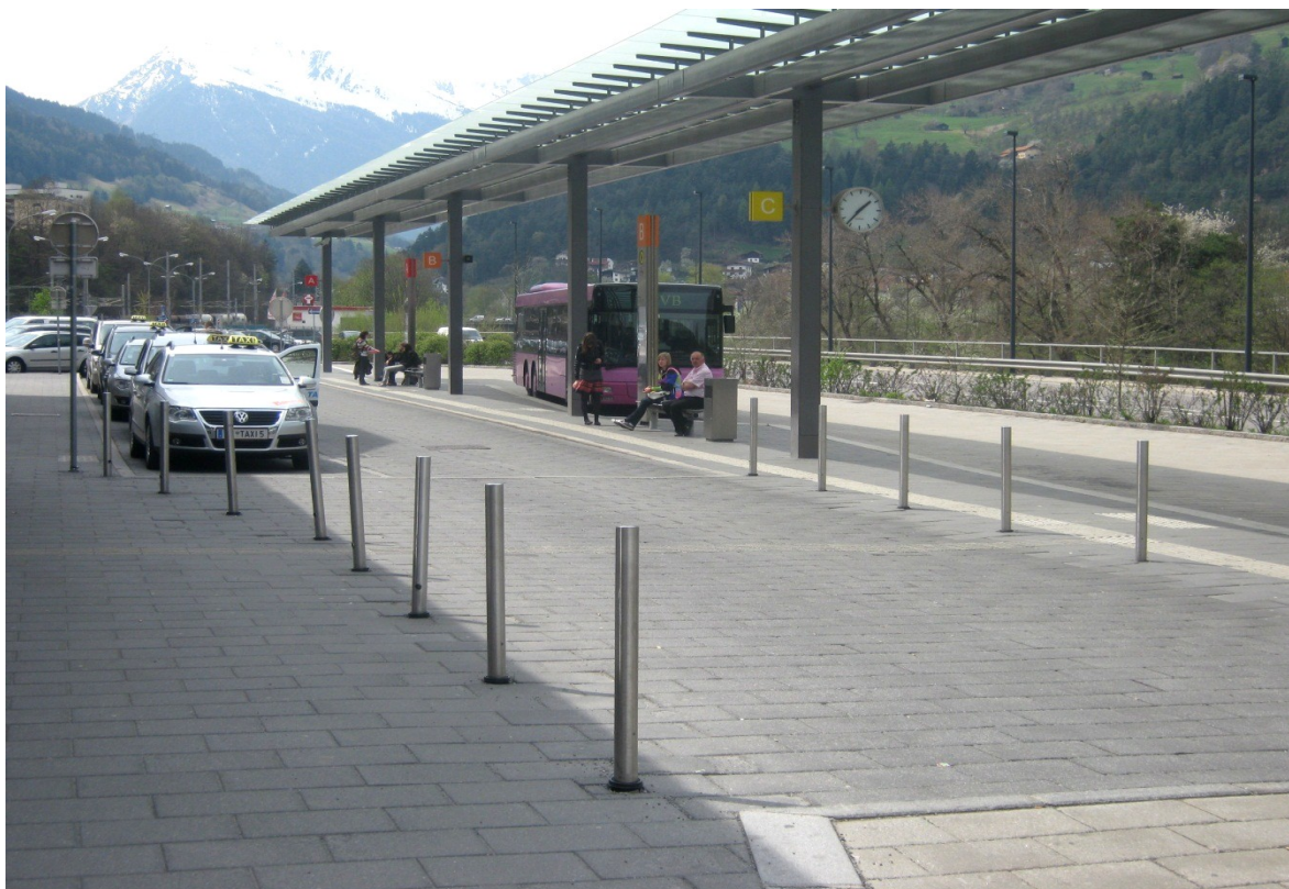
Rys.VIII.9. Stacja Landeck – Zams. (źródło: zbiory własne)
