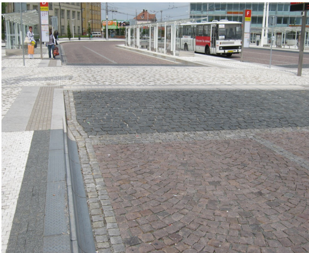
Rys. VIII.16. Podwyższony peron przystankowy- przejścia pomiędzy peronami dla niepełnosprawnych (Źródło materiały własne).
