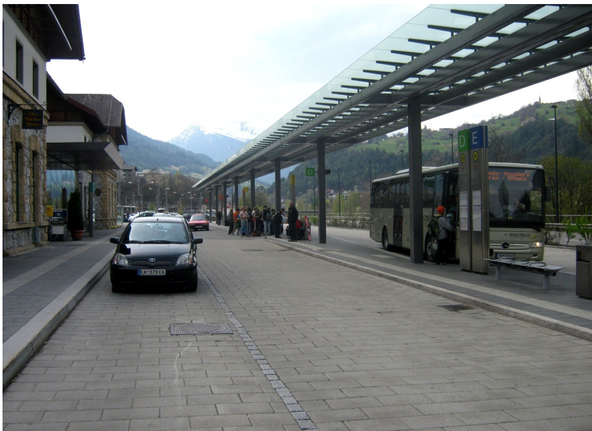
Rys.VIII.10. Stacja Landeck – Zams. (źródło: zbiory własne)
