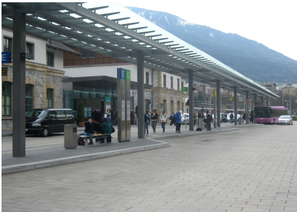
Rys.VIII.7. Stacja Landeck – Zams. (źródło: zbiory własne)
