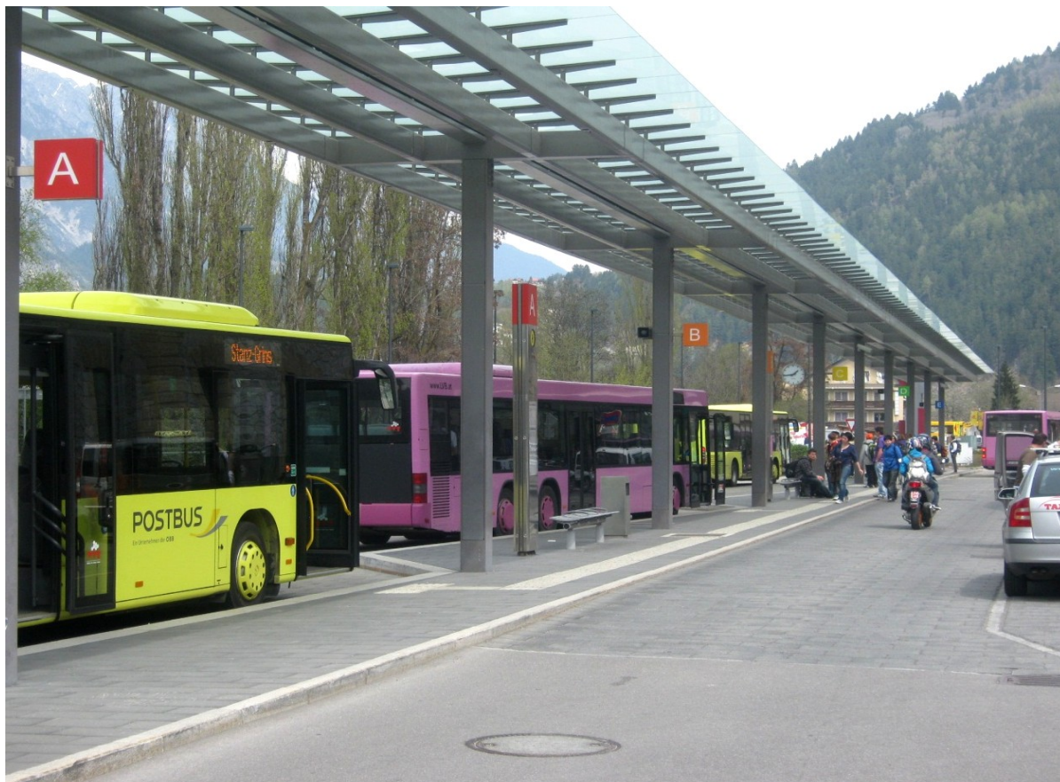
Rys.VIII.8. Stacja Landeck – Zams. (źródło: zbiory własne)
