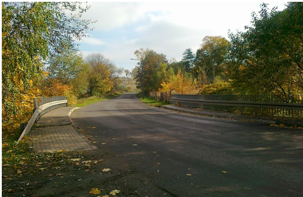
Zdj.nr 3. Widok dojazdu do mostu od strony ul. Wrocławskiej, w stronę dzielnicy Poniatów.
