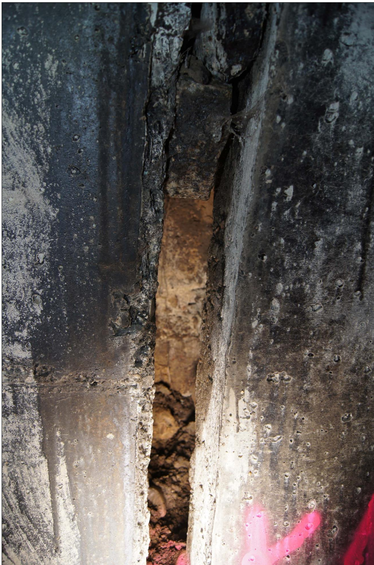
POTOK SZCZAWNIK – KANAŁ ZACHODNI – strona zach. obudowy – cz. kawerny K1.
