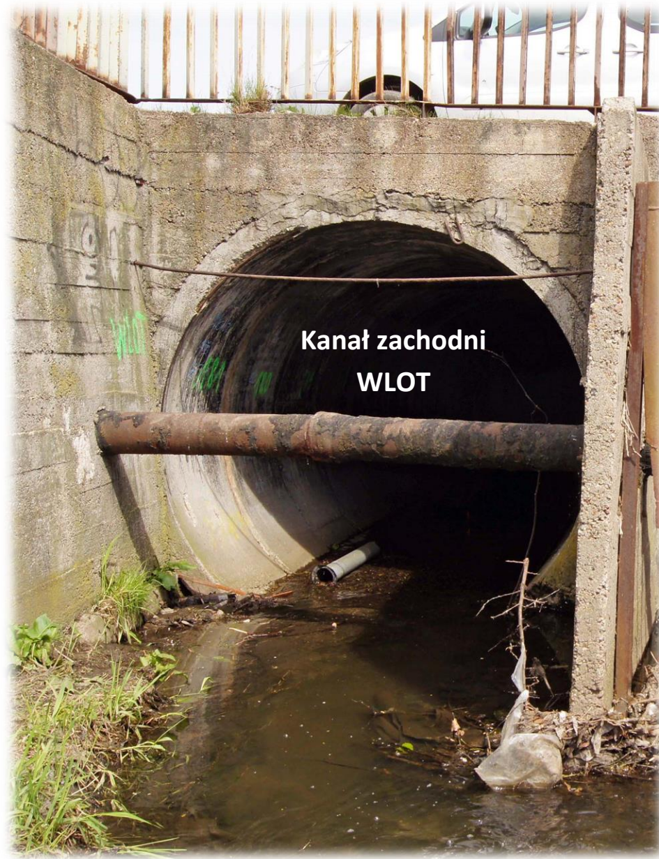
POTOK SZCZAWNIK – dokumentacja fotograficzna zakrytej części potoku – KANAŁ ZACHODNI
