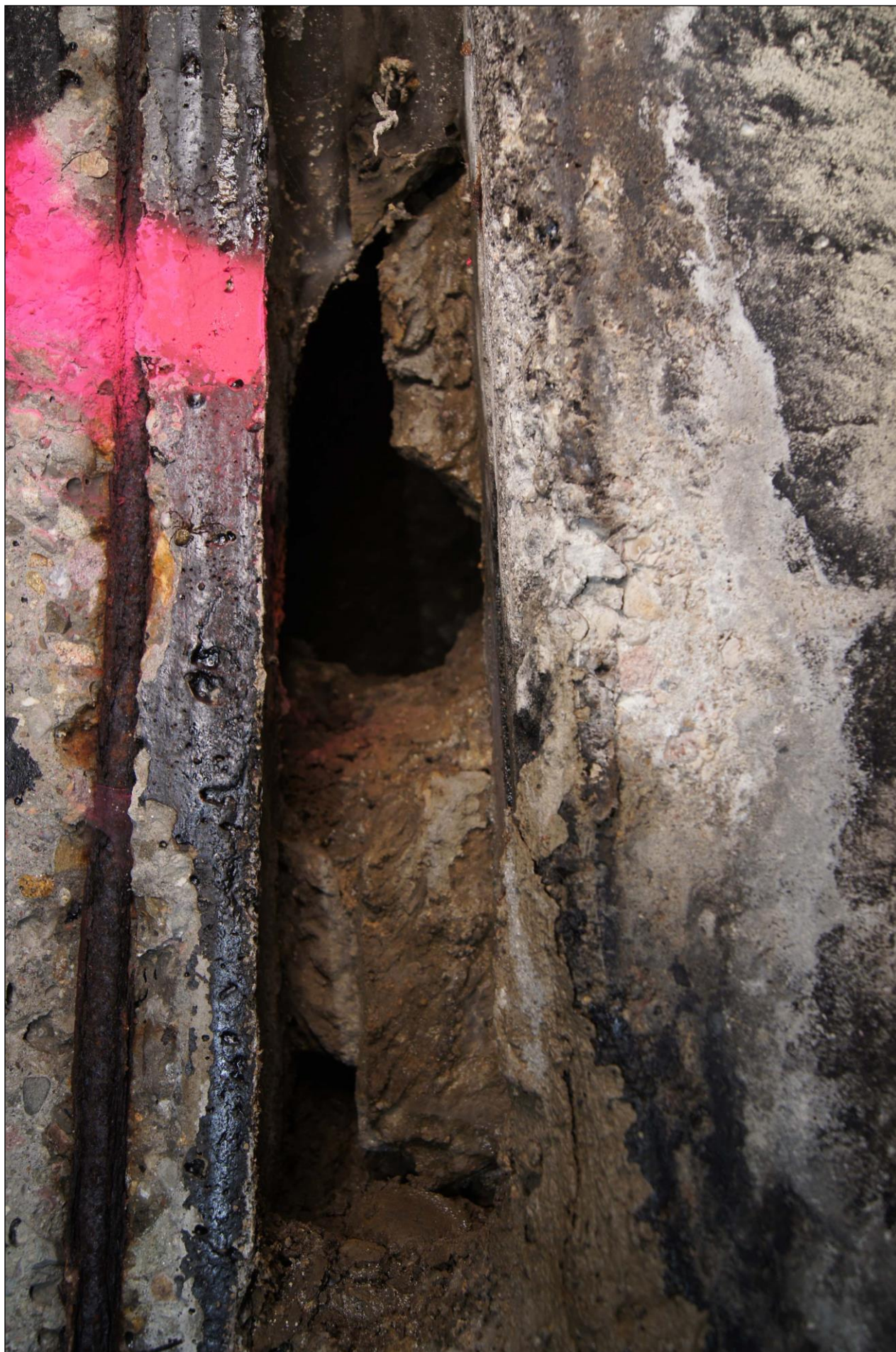
POTOK SZCZAWNIK – KANAŁ ZACHODNI – strona wsch. obudowy – cz. kawerny K2.
