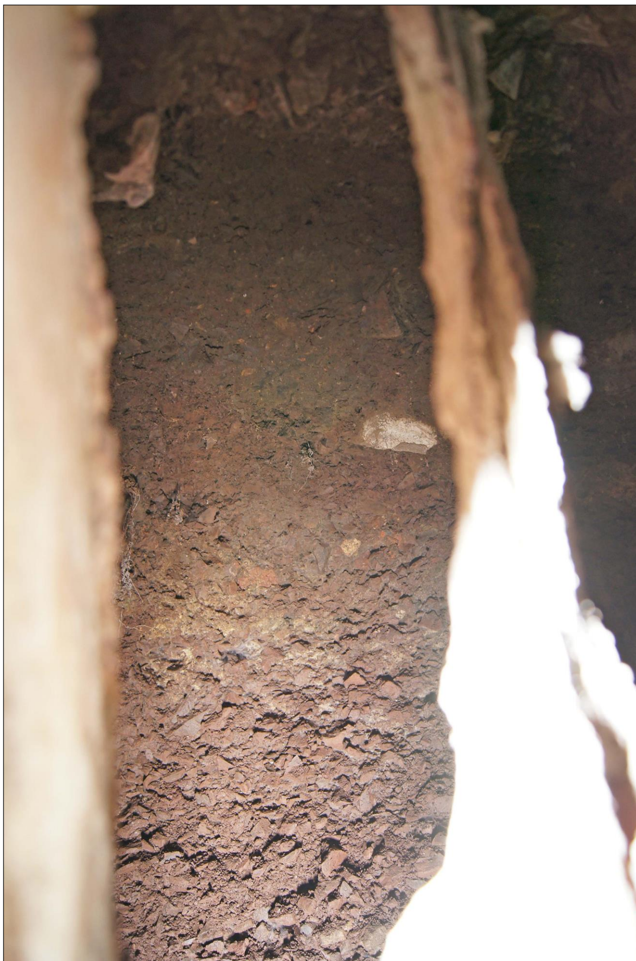
POTOK SZCZAWNIK – KANAŁ ZACHODNI – strona zach. obudowy – cz. kawerny K5.
