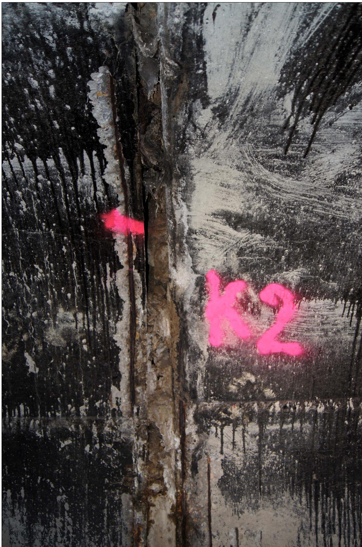
POTOK SZCZAWNIK – KANAŁ ZACHODNI – strona wsch. obudowy – rejon kawerny K2.
