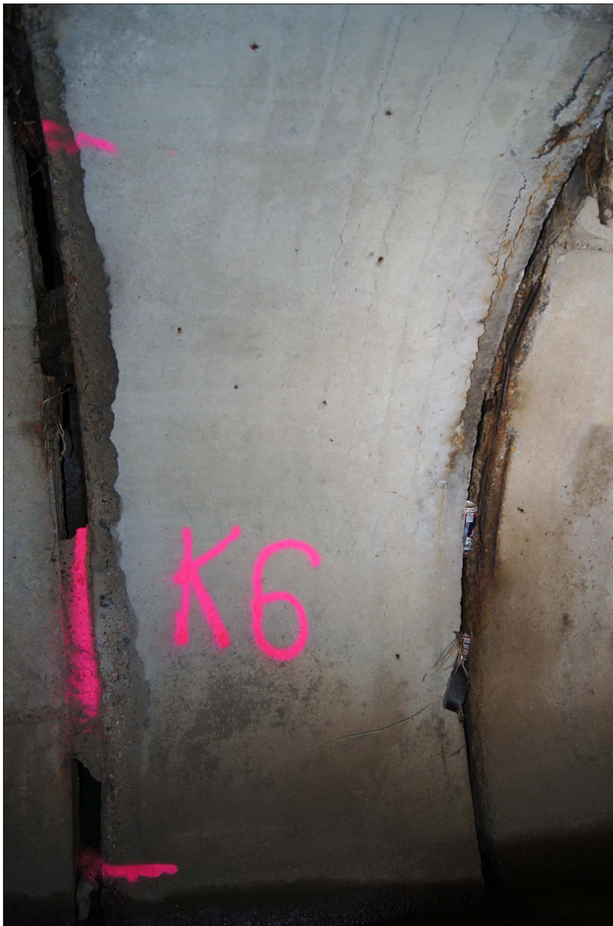
POTOK SZCZAWNIK – KANAŁ ZACHODNI – strona wsch. obudowy – rejon kawerny K6.
