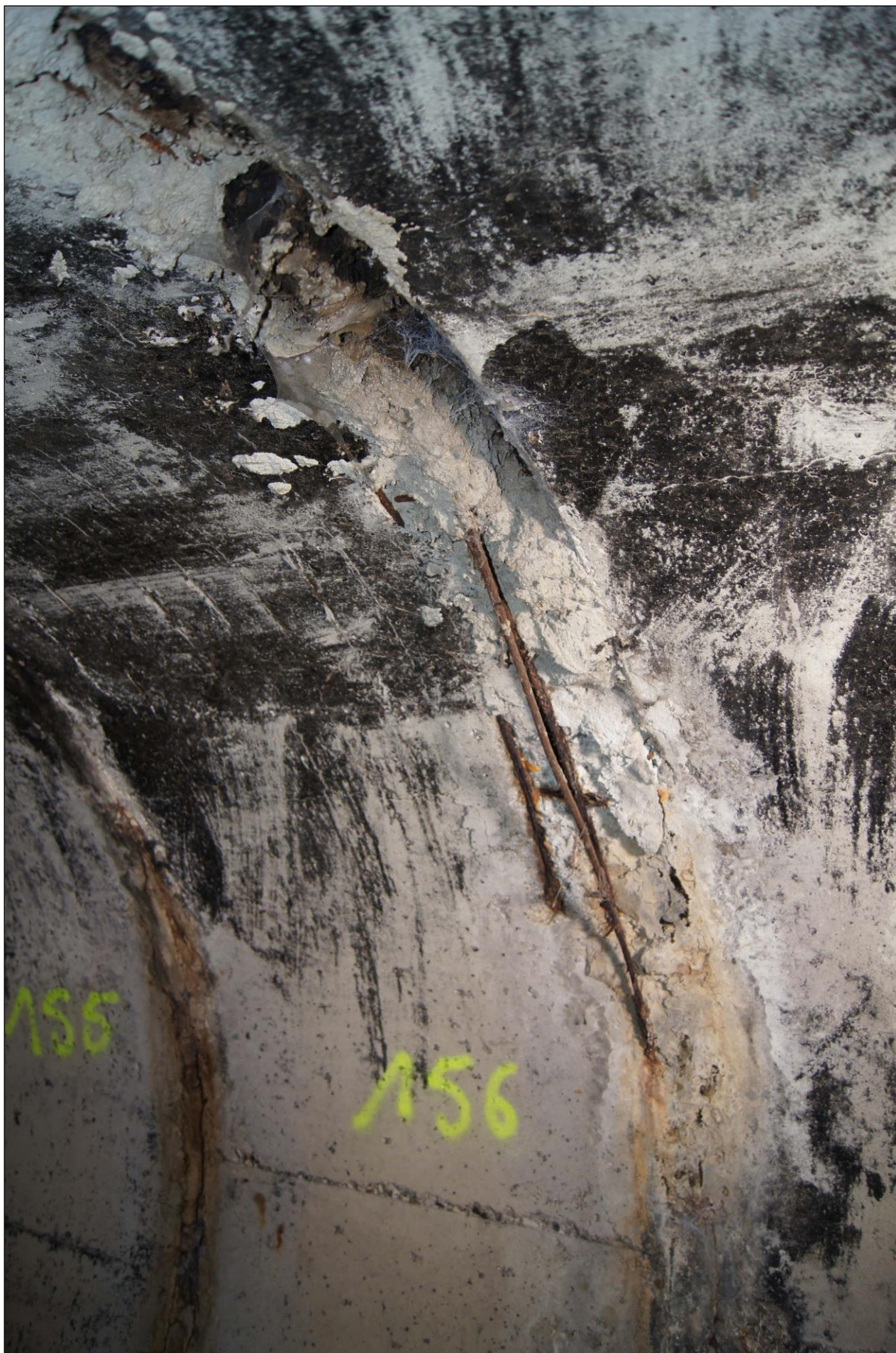
POTOK SZCZAWNIK – KANAŁ WSCHODNI – strona wsch. obudowy – zbrojenie kręgu.
