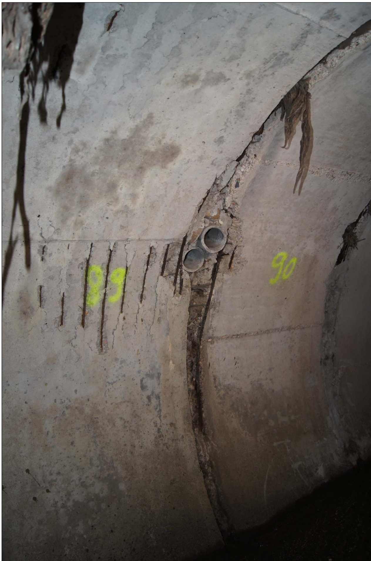
POTOK SZCZAWNIK – KANAŁ WSCHODNI – strona wsch. obudowy – wpusty kd-2x100.
