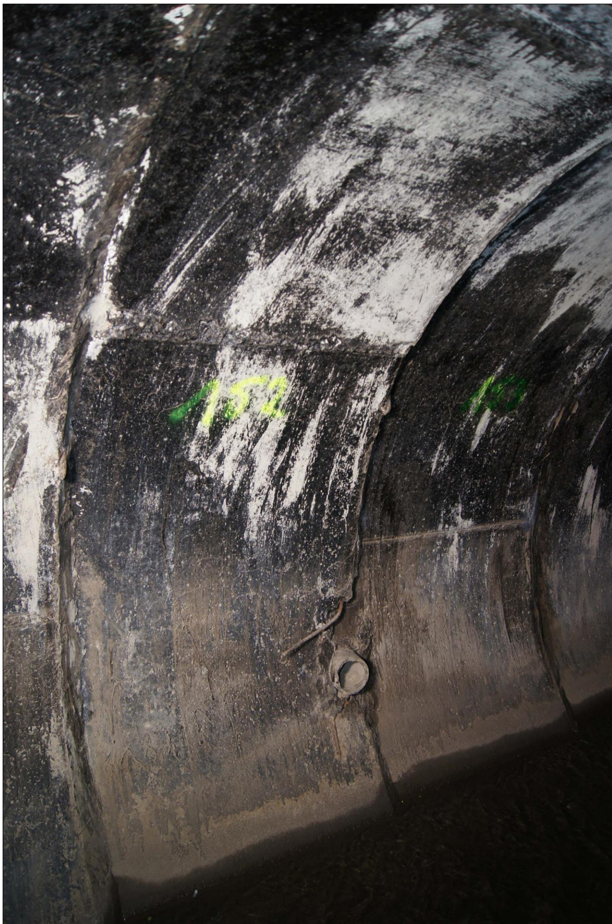
POTOK SZCZAWNIK – KANAŁ WSCHODNI – strona wsch. obudowy – wpust kd-100.
