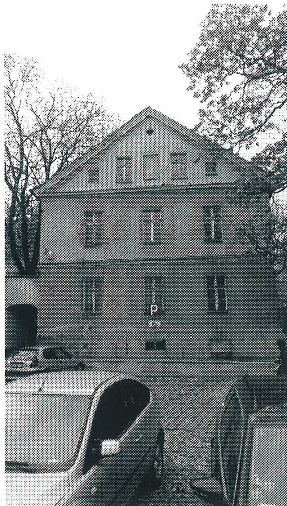
Widok od strony północno-wschodniej
