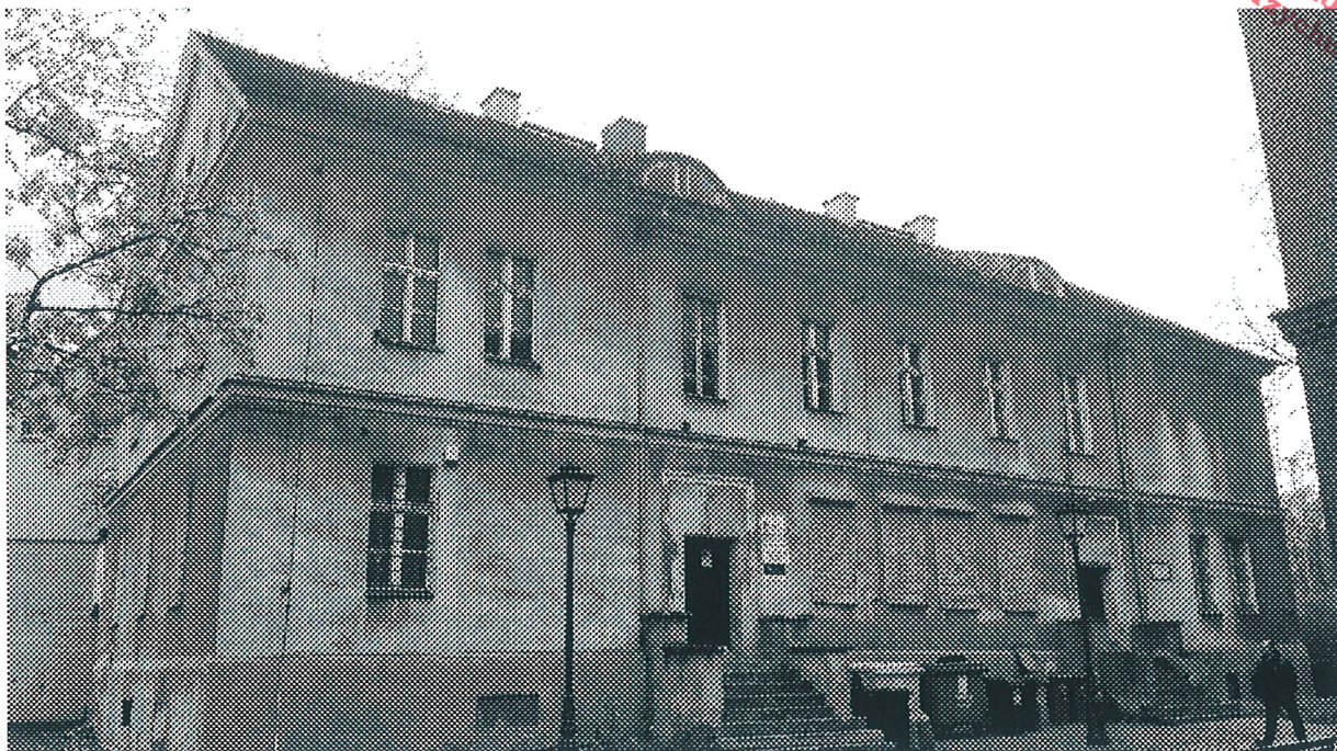
Widok ściany północnej.
