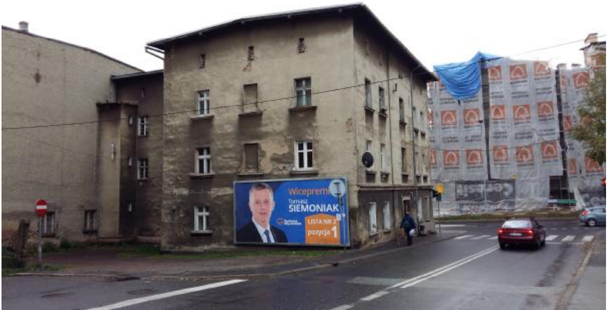
Widok od strony północnej
