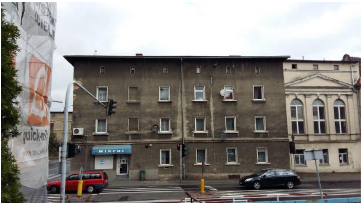
Widok od strony południowej
