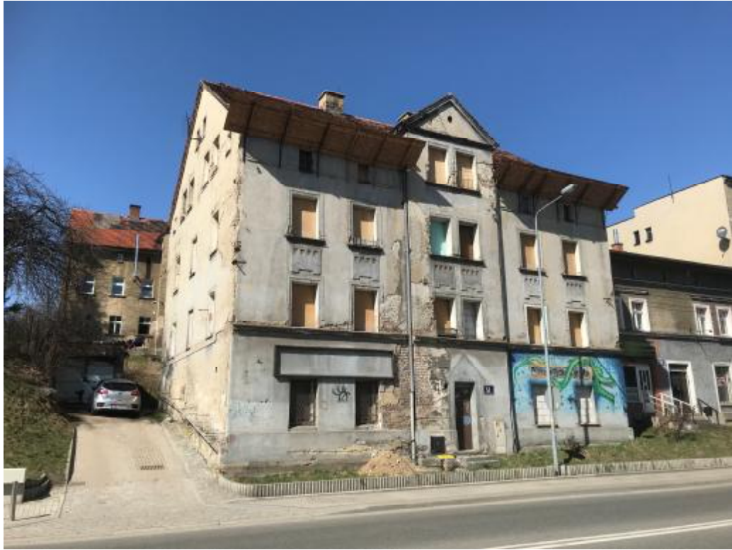
Widok od strony wschodniej – wejścia do części użytkowej
