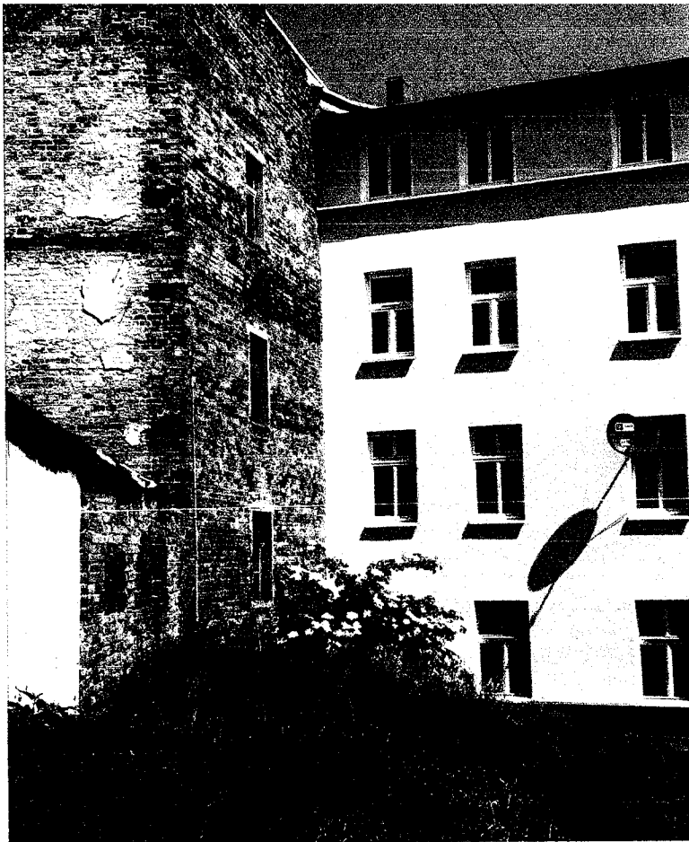
ul. Moniuszki 32a w Wałbrzychu –widok od strony południowej
