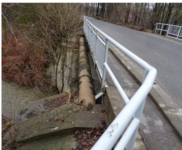
Fot. 4.2. Istniejący wodociąg wD200, zlokalizowany tuż przy obiekcie mostowym.
