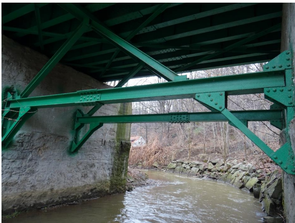
Fot. 4.6. Podparcie przęsła dodatkowymi zastrzałami opartymi na rozporach stabilizujących przyczółki.
