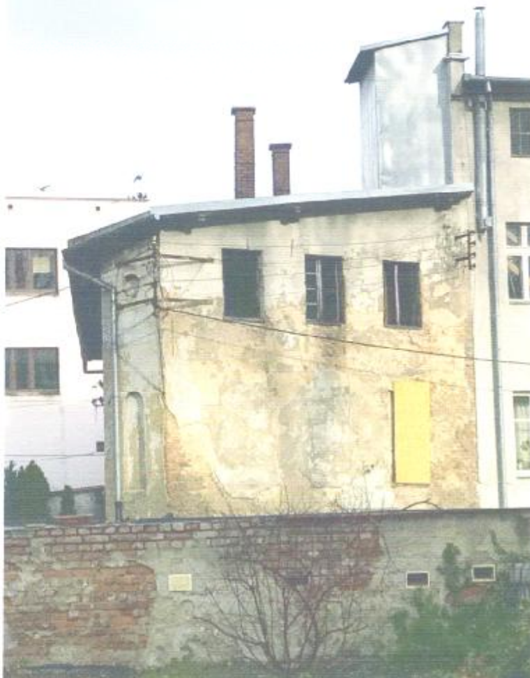
Widok od strony południowej
