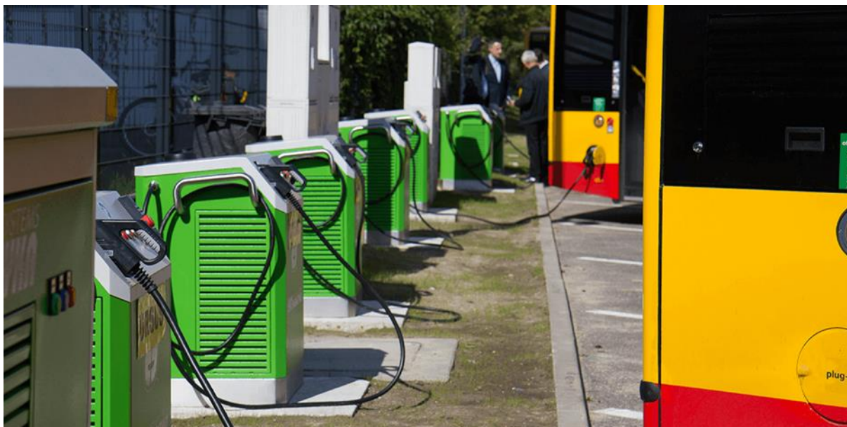
Rysunek 1. Punkty ładowania Plug-in autobusów.
