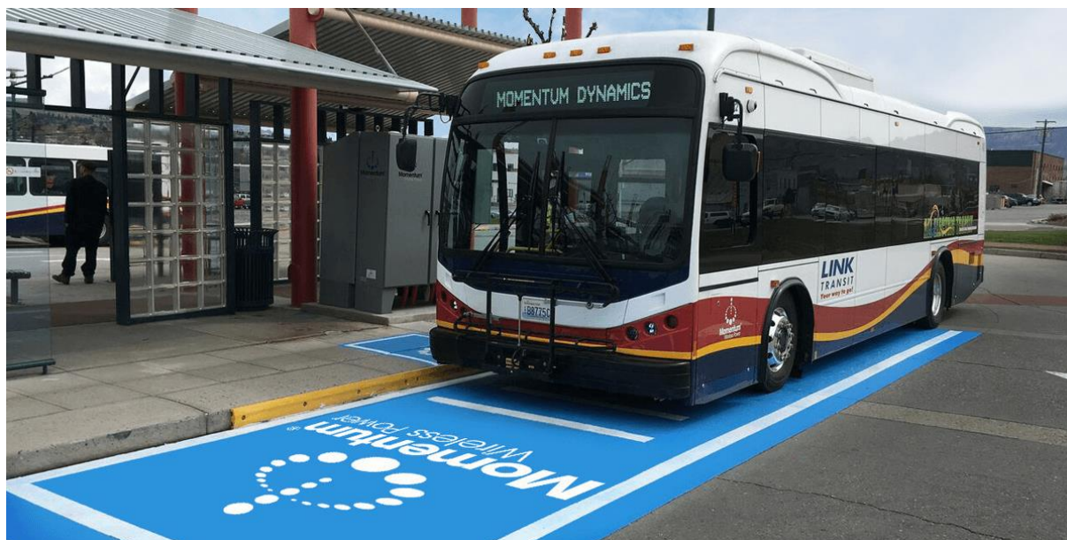
Rysunek 2. Przystanek z zainstalowanym stanowiskiem ładowania indukcyjnego.
